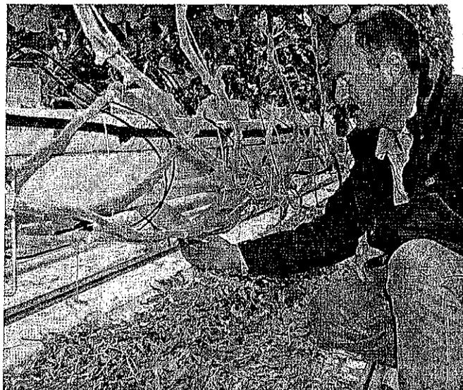
La fumée issue de la cogénération contenant du CO<sub>2</sub> circule dans la serre par des tuyaux souples en plastique transparent. Peu de serristes ayant une installation de cogénération utilisent cette technique, craignant l'effet des gaz nocifs sur les plantes. Un lavage des fumées à l'urée s'impose avec des contrôles en continu de la qualité du CO<sub>2</sub>.
